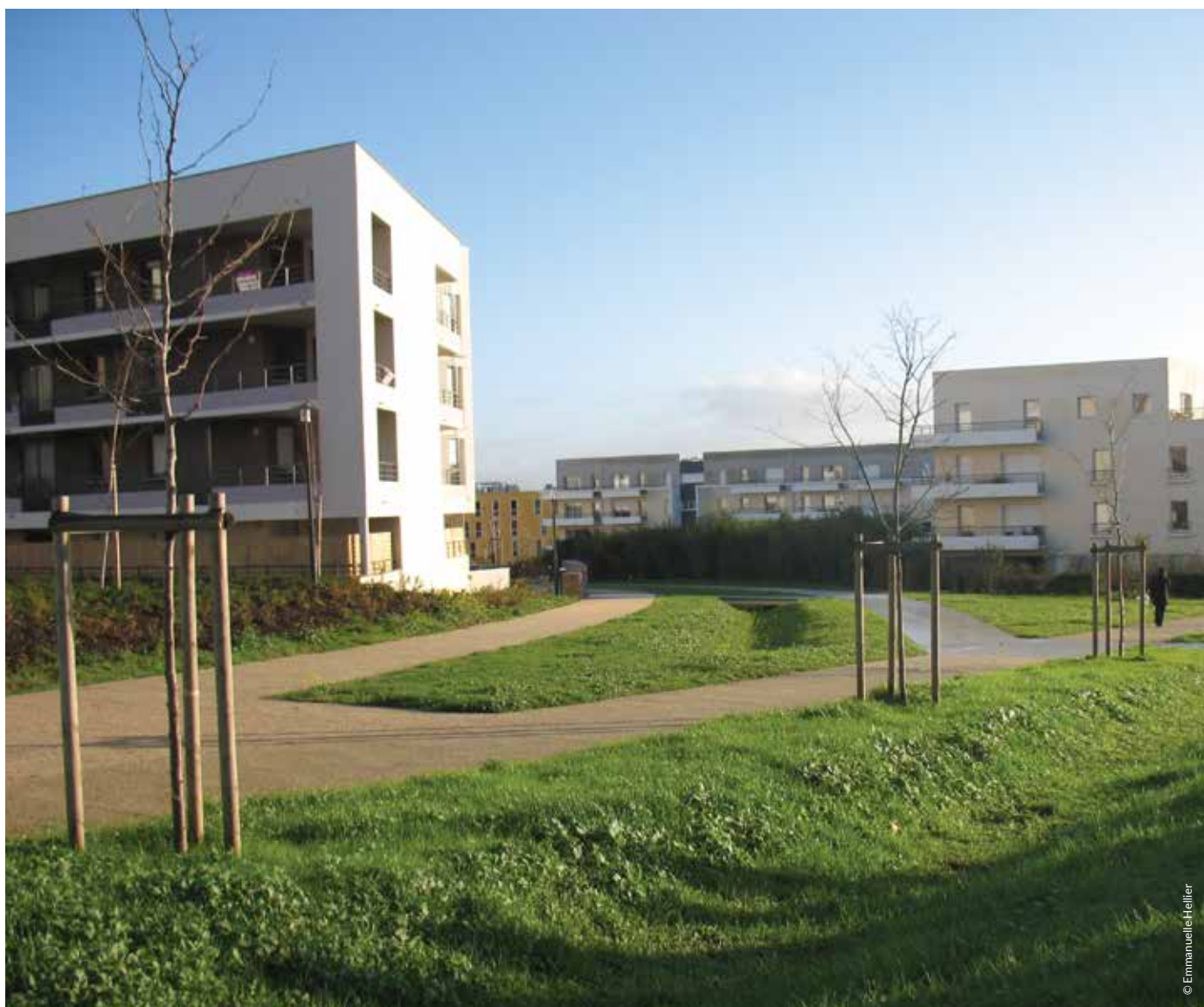
Les noues sont des fossés servant à collecter temporairement l'eau de pluie (quartier de Beauregard à Rennes)
