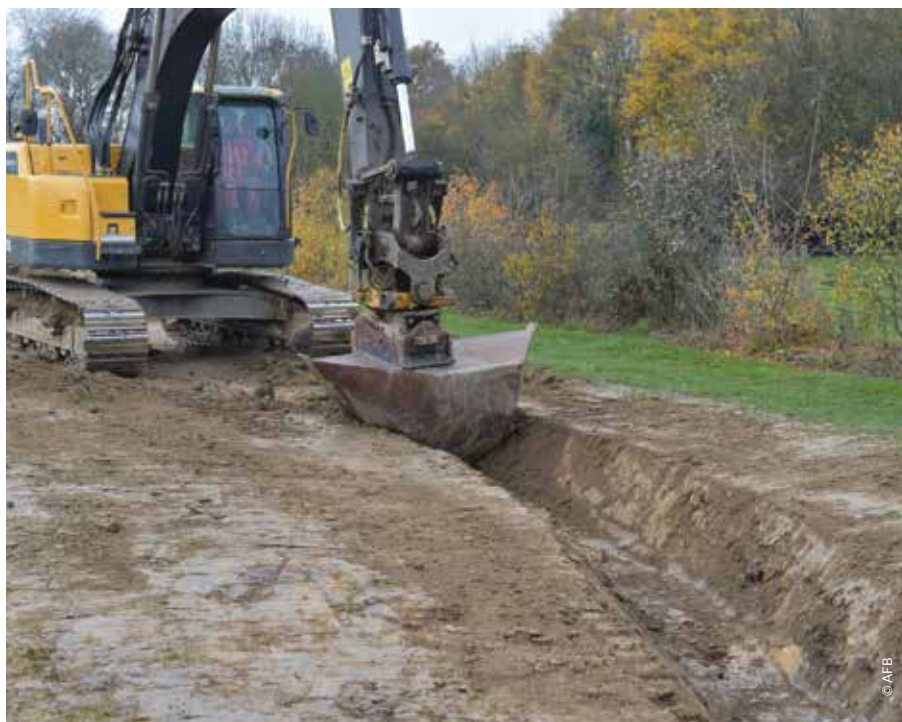
Opération de restauration d'un cours d'eau
