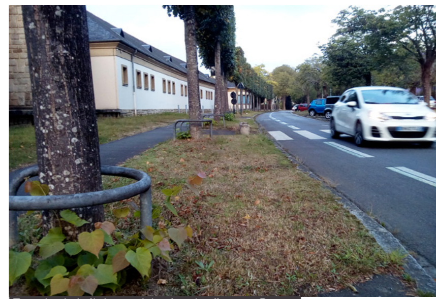
Trottoir végétalisé pour éviter le ruissellement, Rennes
