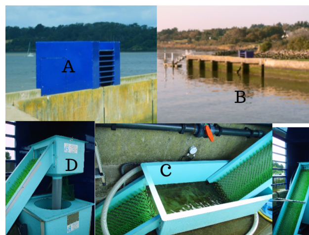
FIGURE 4: La passe à anguille du mur Guide Eau, passe secondaire, 2008-2016.
