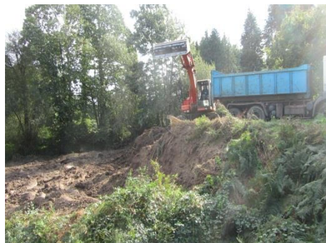
Photo 5 : Travaux de suppressions de remblai
