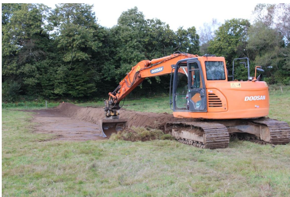
Photo 3 : Photos des travaux du Volet 3-3
