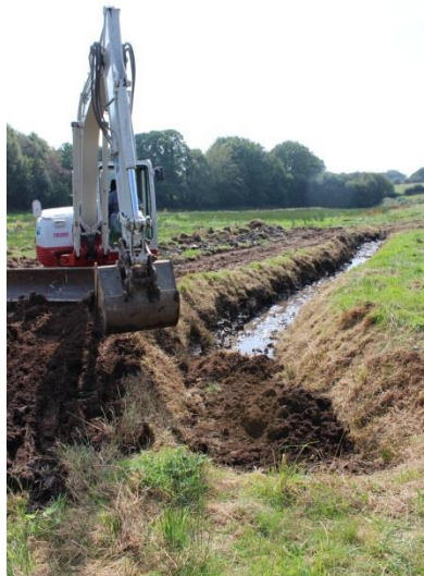
Photo 1 : Travaux de comblements de fossés drainants
